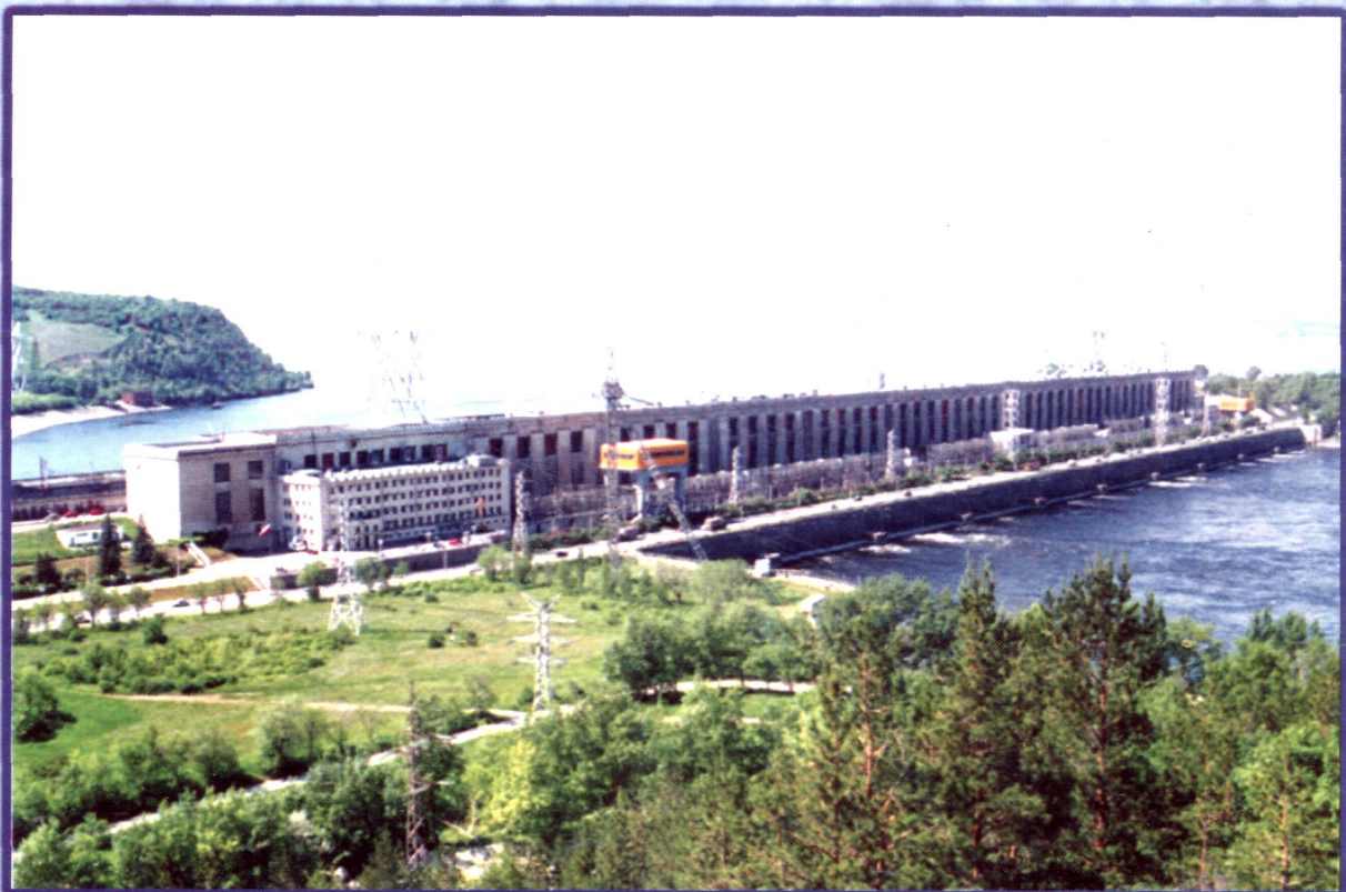
Здание Жигулёвской (бывшей Куйбышевской) ГЭС. Фото Е.А. Бурдина, 2004 г.
