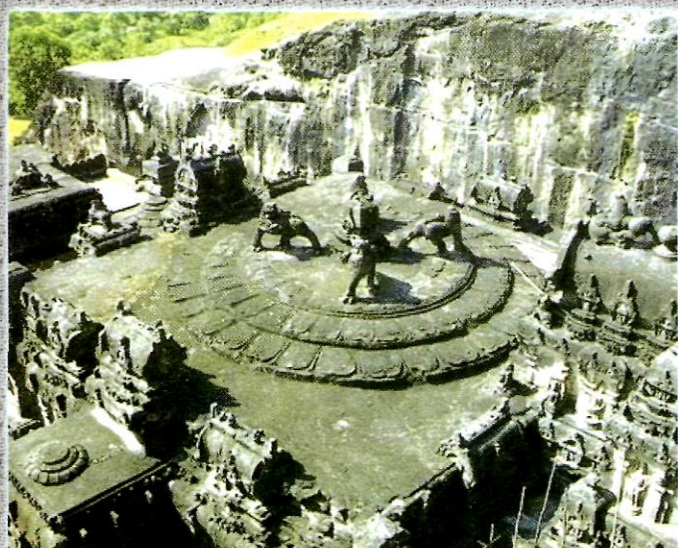
Рис. 1. Бетонные полы в одном из храмов Индии
