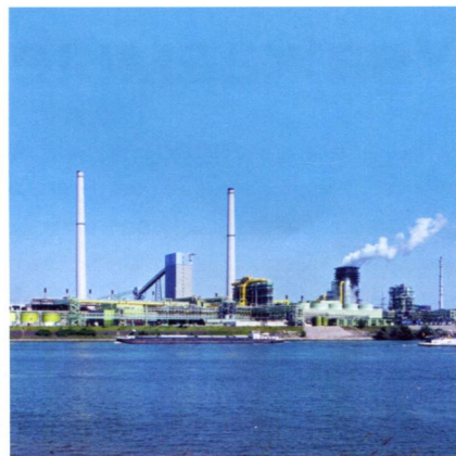
Фото на обложке: Коксовый завод Швельгерн компании ThyssenKrupp Steel Europe в Дуйсбурге, Германия ThyssenKrupp Industrial Solutions AG www.thyssenkrupp-industrial-solutions.com frank.redemann@thyssenkrupp.com
